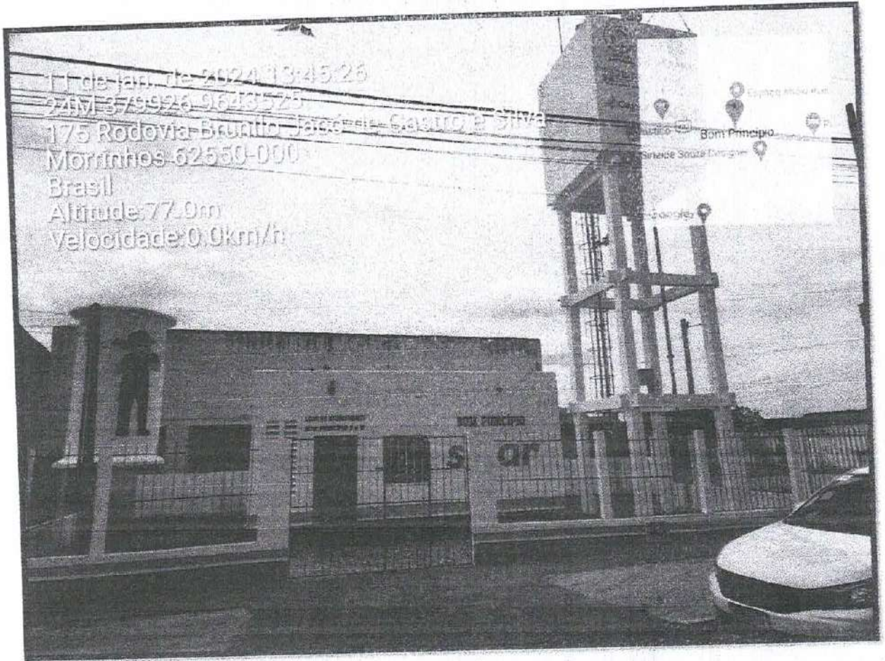
Imagem 03 – Reservatório elevado existente
